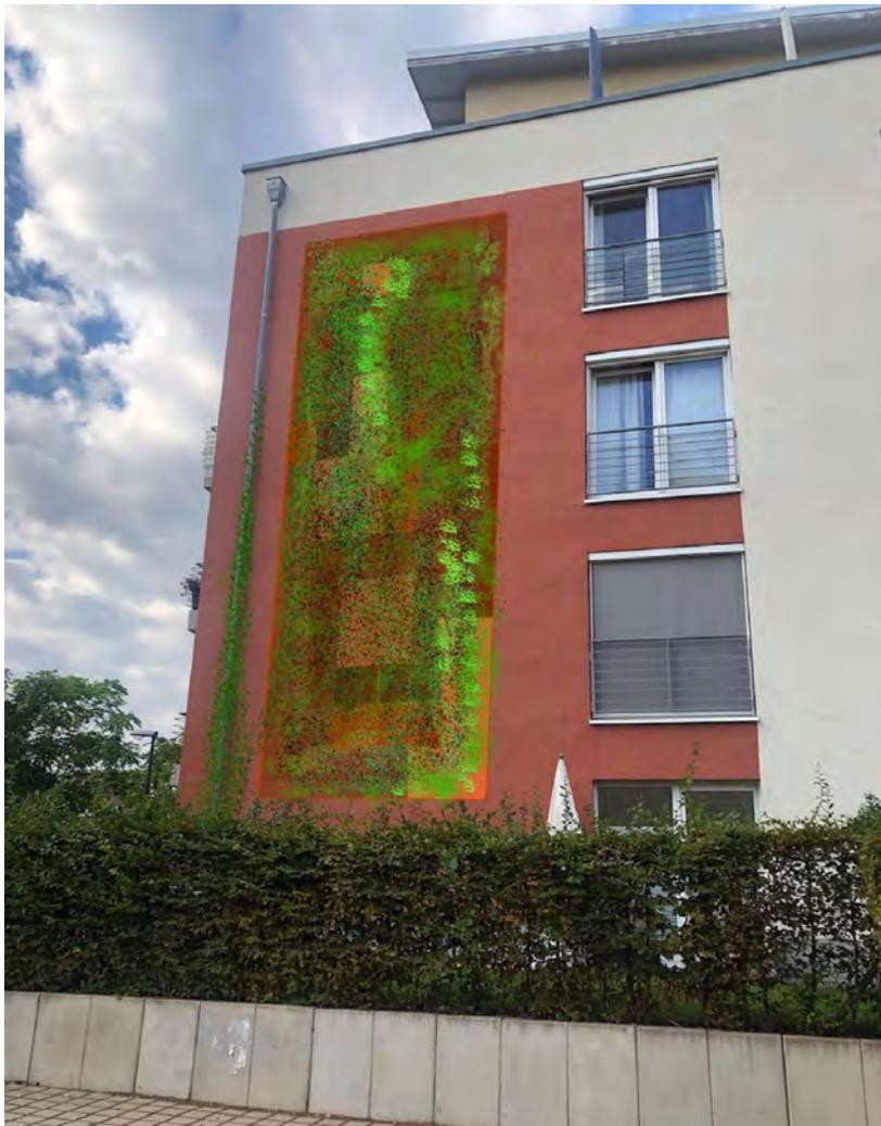
*Bild 11: Magerpflanzen-Elemente an der Fassade, Ranke am / um Fallrohr*
